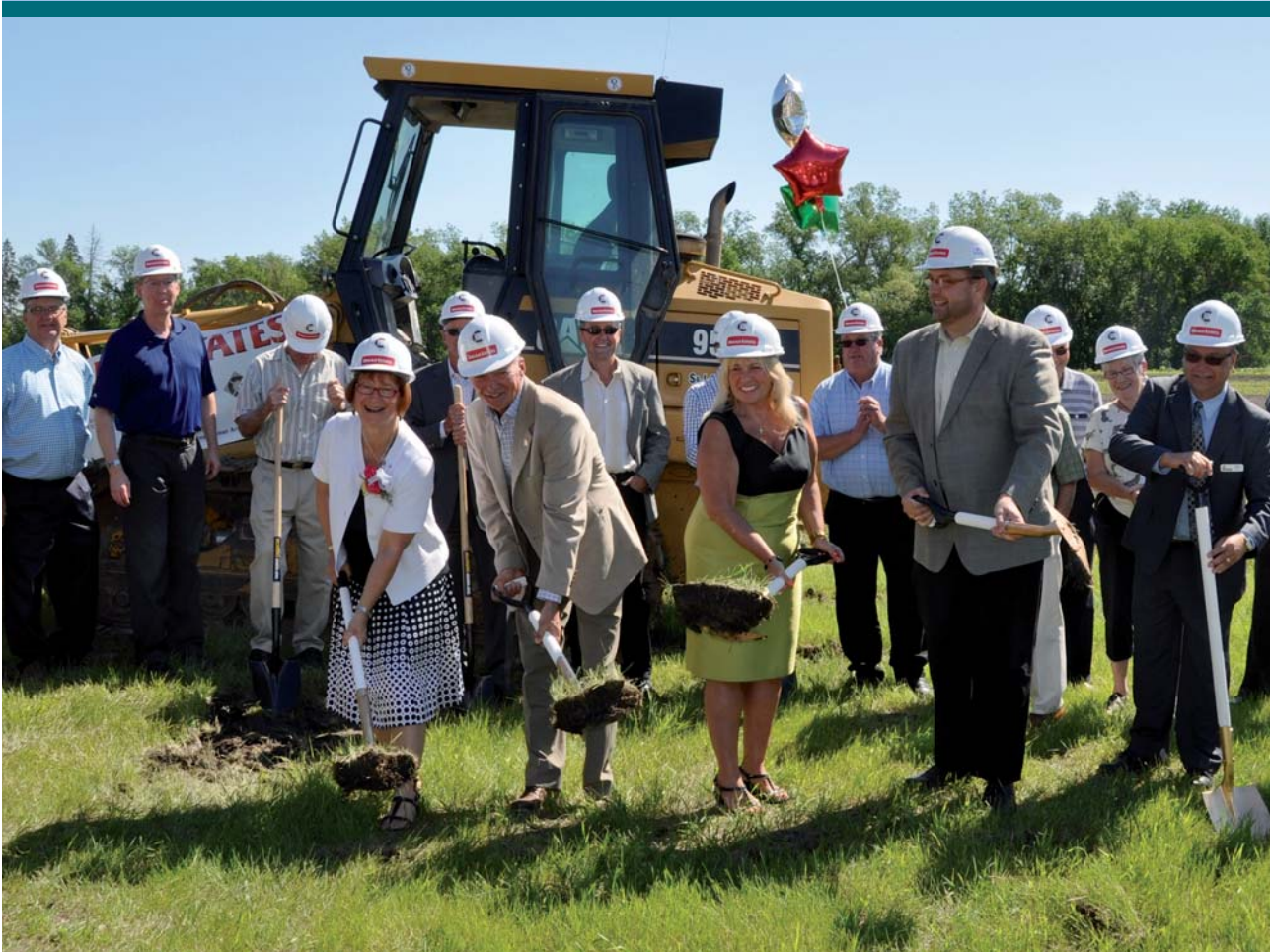
Ο Μη Κερδοσκοπικός Στεγαστικός Συνεταιρισμός Ηλικιωμένων Springfield Seniors γιορτάζει την έναρξη κατασκευής στεγαστικού συνεταιρισμού 47 μονάδων, αξίας 14.500.000 $, για την παροχή ποιοτικής και οικονομικά προσιτής στέγασης στο Springfield, ΗΠΑ
