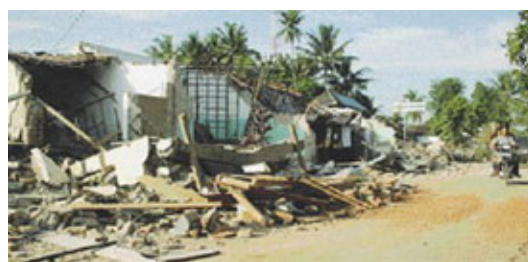
Des scènes de destruction causées par le tremblement de terre au centre de Java.
