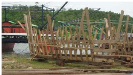
Construction d'un Palung/ Maison bateau utilisé par les membres des coops pour capturer le poisson
